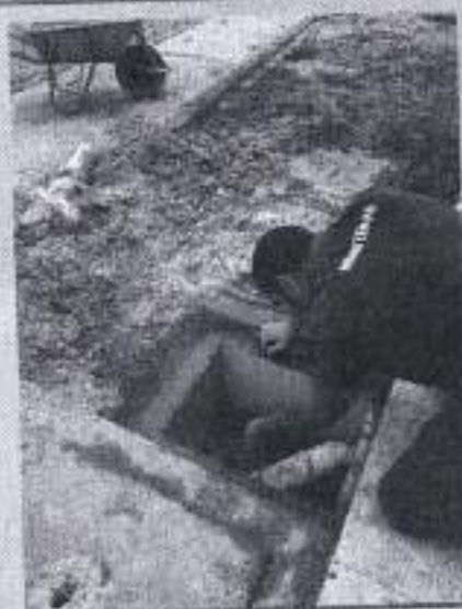
Obra: HOSPITAL DA MULHER DO RECIFE
